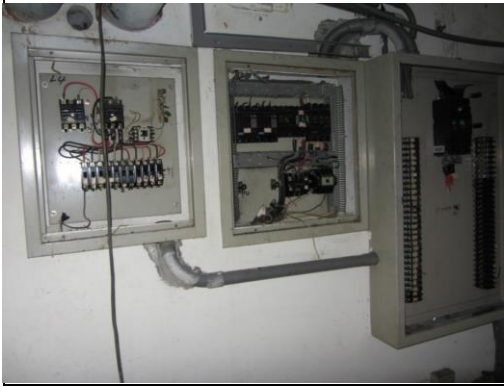
照片1：室內電氣開關箱毀損進行整復
