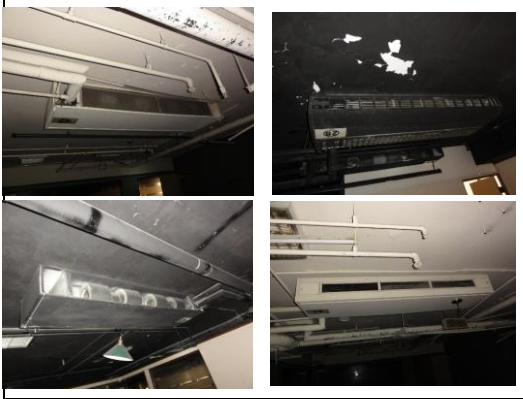
照片1：空調送風機拆除(180*80*25cm)
