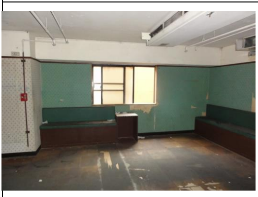
照片7：單面牆板拆除並保留消防設備
