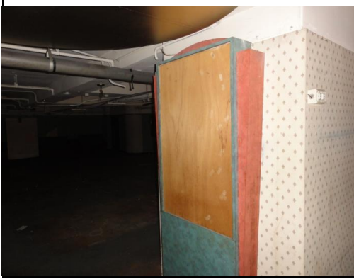
照片3：柱體造型裝飾牆拆除
