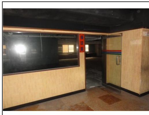
照片8：雙面牆板及玻璃隔屏、門片拆除
