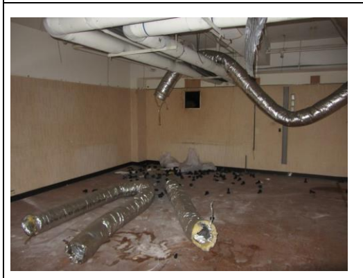
照片1：風管等全部拆除
