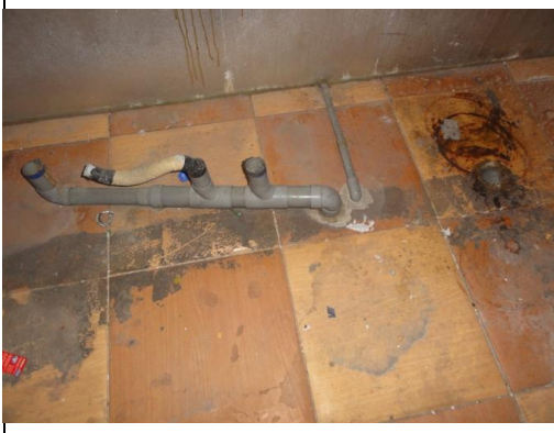
照片3：舊廚房地板管線整理拆除
