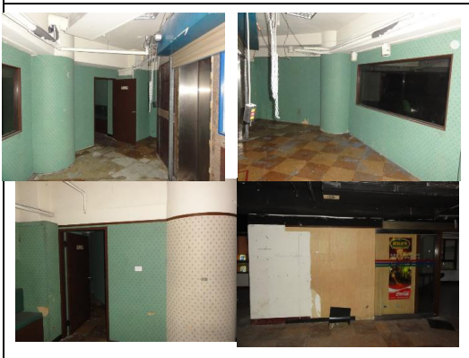
照片7：室內粉刷
