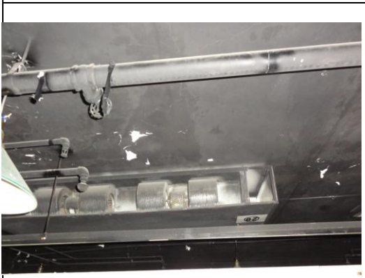
照片7：空調送風機拆除(180*80*25cm)
