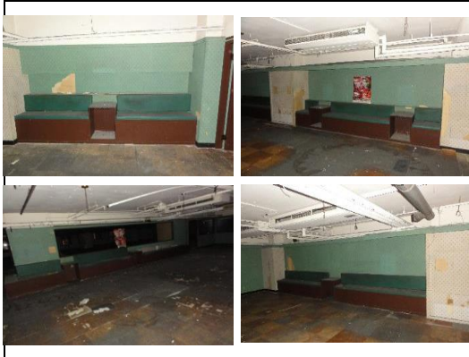
照片3：舊木作椅子及單面牆板拆除
