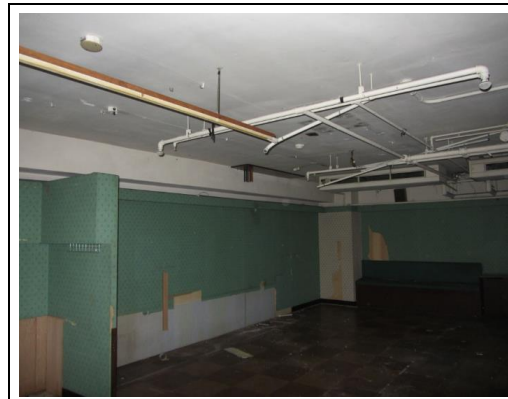
照片8：室內粉刷
