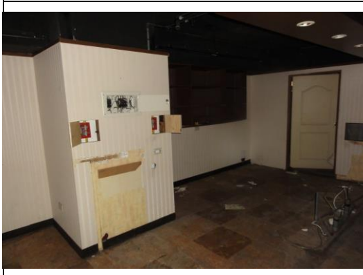
照片5：單面牆板拆除並保留消防設備
