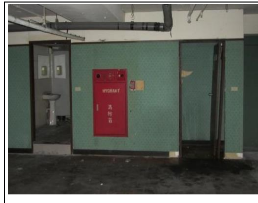
照片8：廁所門片安裝
