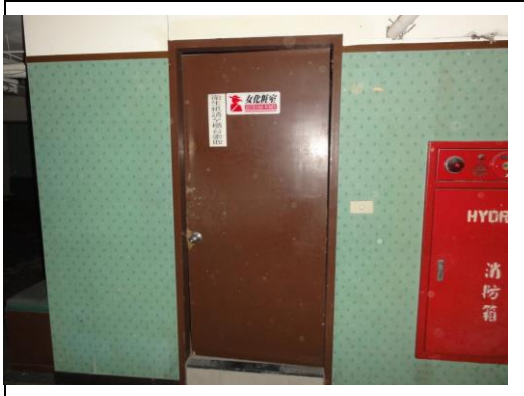
照片3：女廁損壞門片拆除
