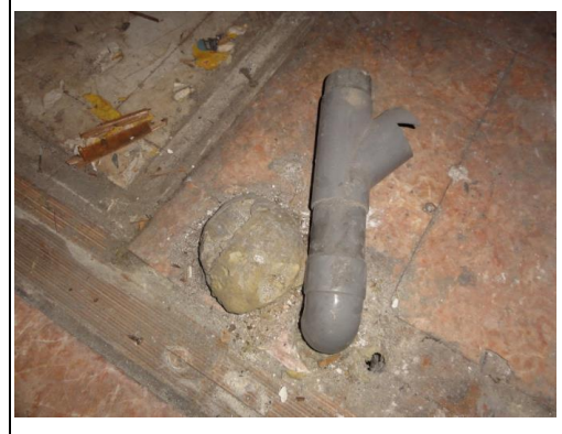
照片8：入門口右方地板2" PVC管整理
