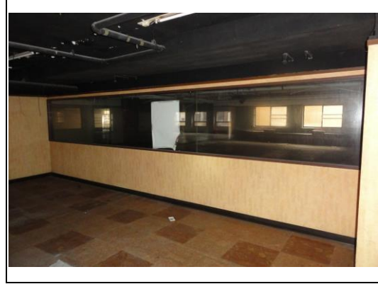
照片2：雙面牆板及玻璃隔屏全部拆除
