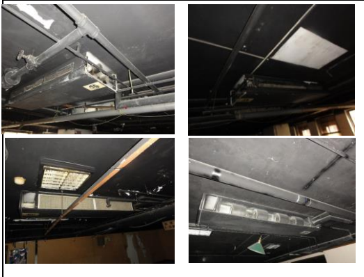
照片3：空調送風機拆除共28台
