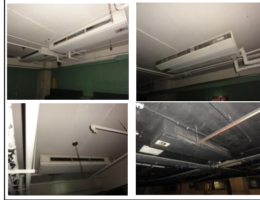
照片2：空調送風機拆除共28台
