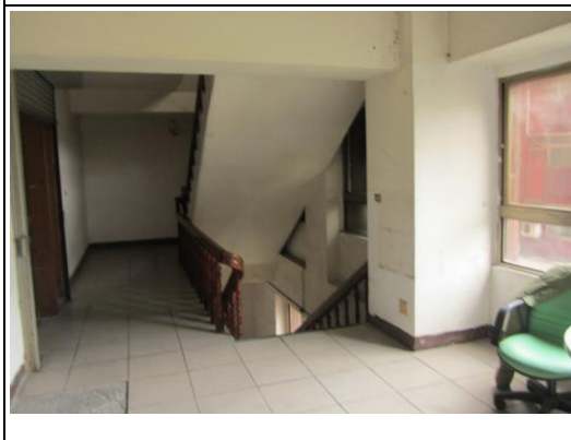
照片5：4樓樓梯間踢腳板粉刷
