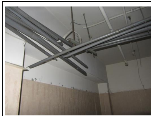
照片4：拆除與整理
