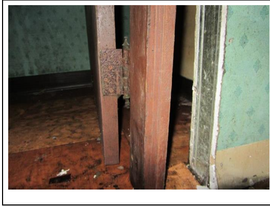
照片1：男廁所門框修理固定
