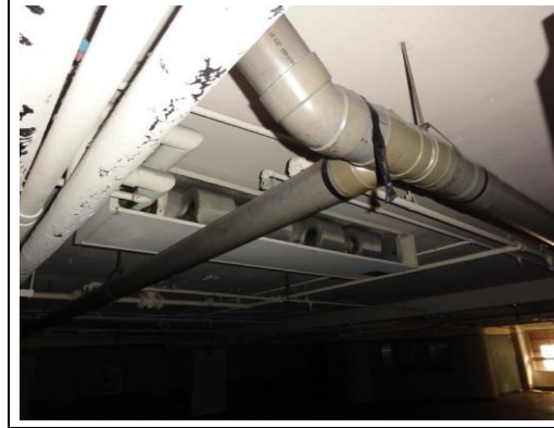
照片2：天花板4" PVC通風管路拆除
