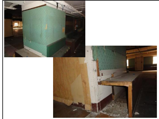
照片4：舊木作椅子拆除及壁紙撕除
