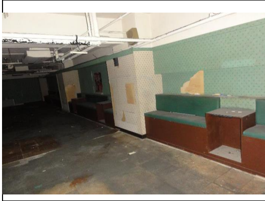
照片1：舊木作椅子及單面牆板拆除
