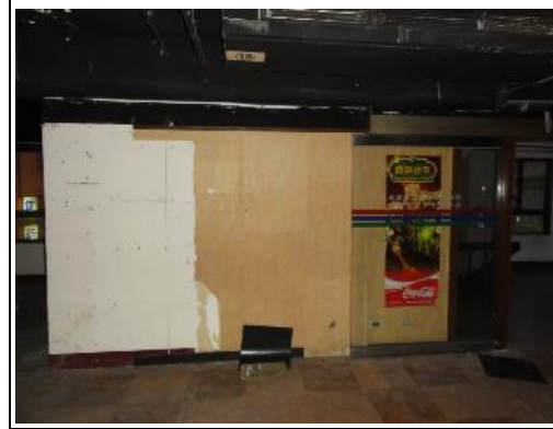
照片2：壁紙拆除及底紙去膠處理
