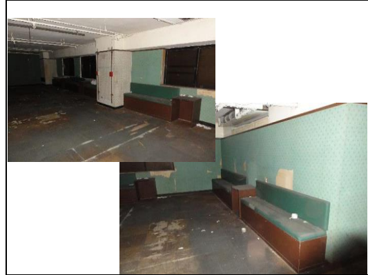
照片2：舊木作椅子及單面牆板拆除
