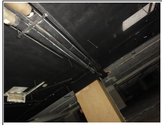
照片6：舊有冰水管路系統拆除
