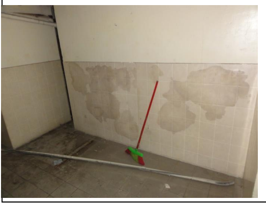
照片1：女廁壁面裝飾磁磚拆除
