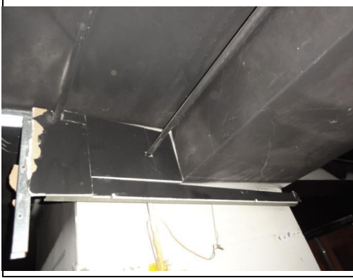
照片1：天花板上固定不良輕隔間鋼架拆除
