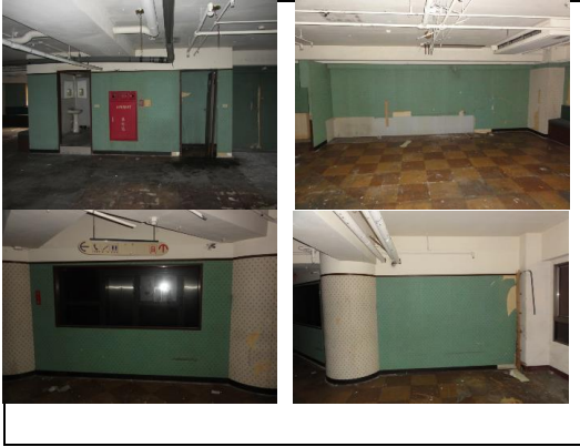
照片1：室內粉刷
