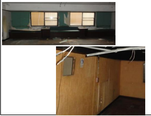
照片1：壁紙拆除及底紙去膠處理
