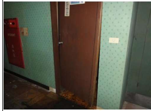
照片2：男廁損壞門片拆除
