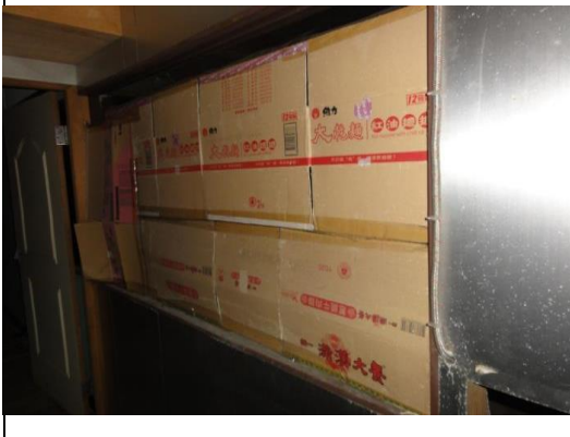
照片5：雙面牆板及玻璃隔屏全部拆除
