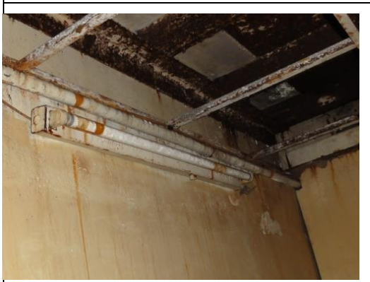
照片7：男廁壁面舊燈具拆除
