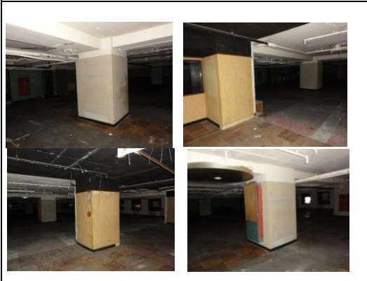
照片3：壁紙拆除及底紙去膠處理
