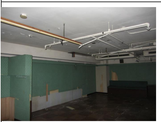
照片7：壁紙撕除及底紙去膠處理
