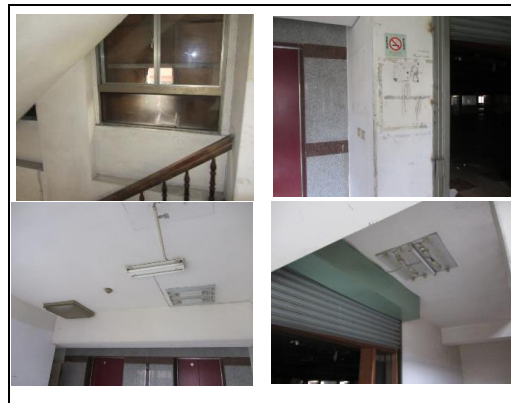
照片6：4樓樓梯間待粉刷
