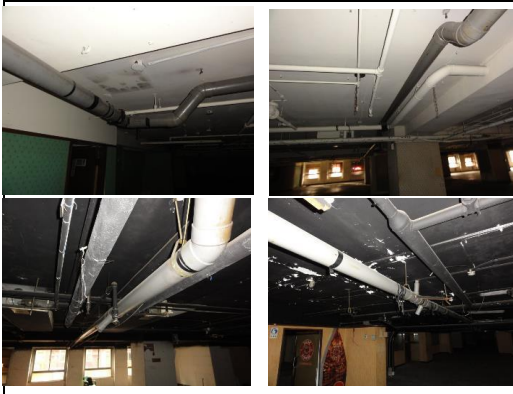
照片1：天花板4" PVC通風管路拆除
