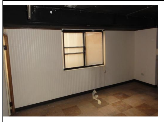
照片6：單面牆板拆除
