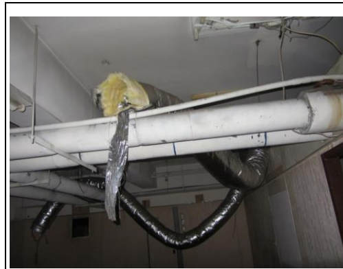
照片2：風管等全部拆除
