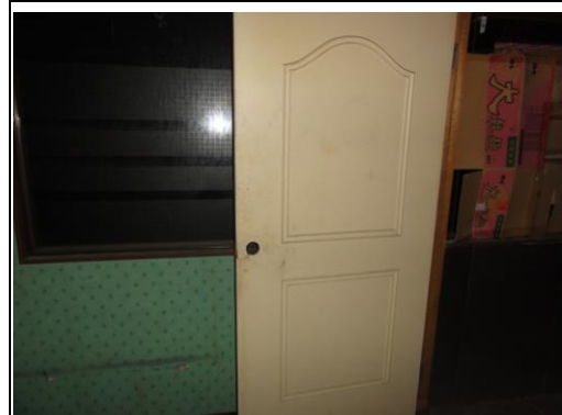
照片4：廚房破損門片拆除
