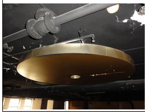
照片2：天花板上圓形造型天花板拆除
