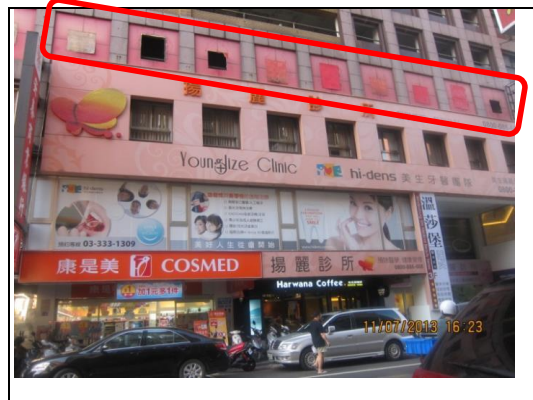
照片8：窗戶室外外部木作裝飾板拆除及吊車作業
