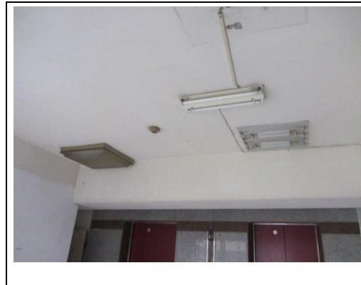
照片4：電梯口舊燈具拆除與移位及新設燈具
