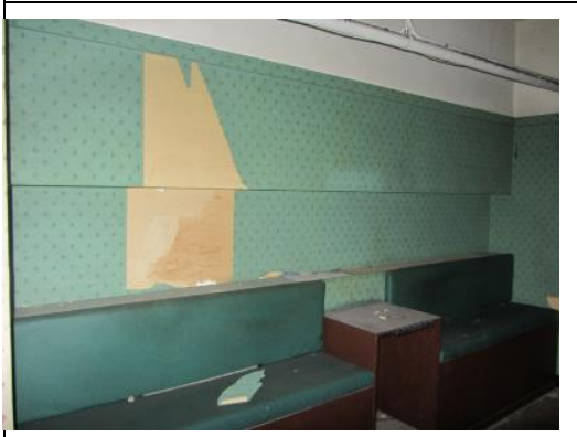
照片5：壁紙撕除及底紙去膠處理
