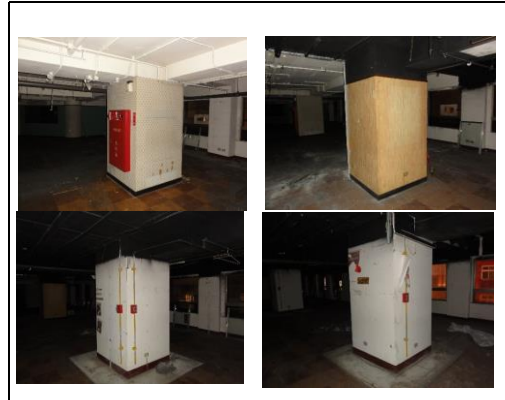
照片4：壁紙拆除及底紙去膠處理
