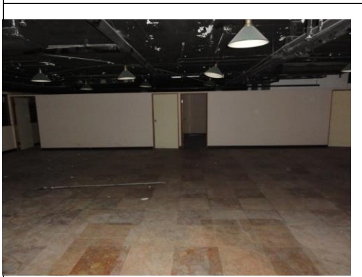
照片5：小型隔間拆除
