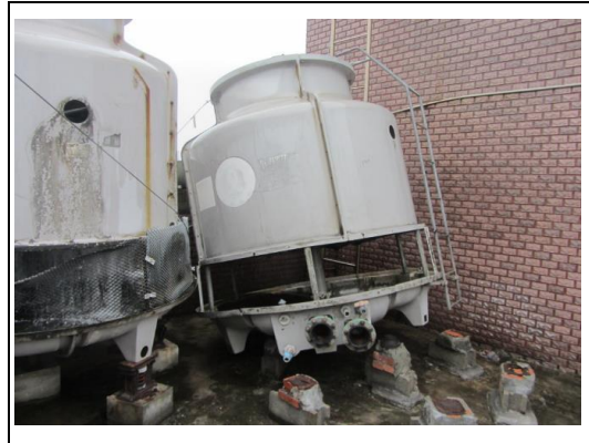
照片6：舊有冷卻水塔分解運棄
