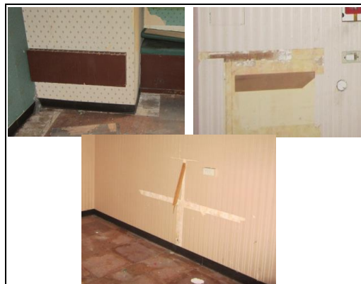
照片8：壁紙撕除表面層、牆上零星附著物拆除
