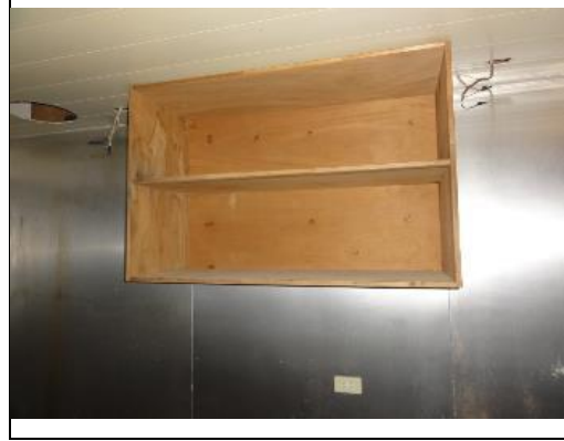
照片2：舊廚房木吊櫃拆除
