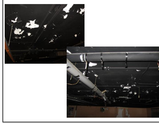
照片4：天花板舊漆剝落處鏟除
