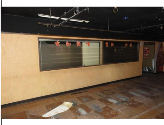
照片3：雙面牆板及玻璃隔屏全部拆除
