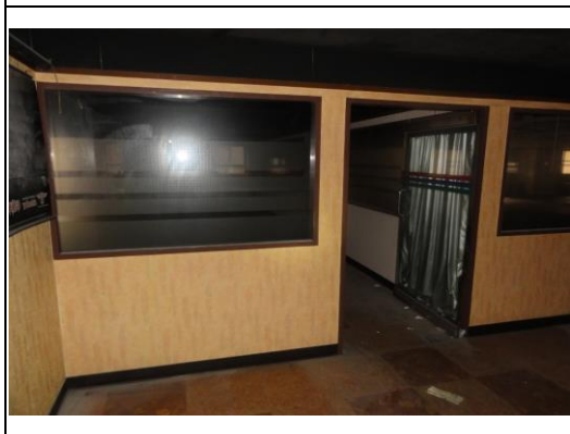
照片7：雙面牆板及玻璃隔屏、門片拆除
