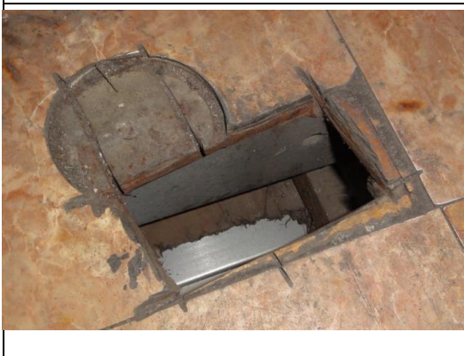
照片7：地板破口鐵工焊接補平
