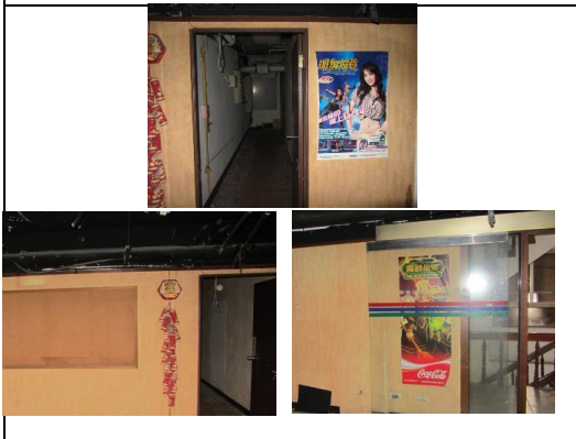
照片5：木吊櫃、海報、裝飾物等拆除
