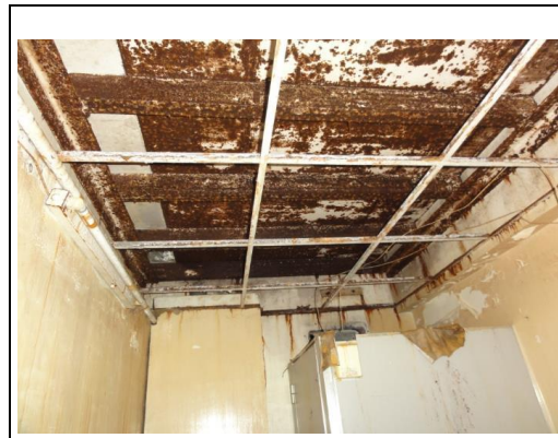
照片6：男廁輕鋼架天花板拆除
