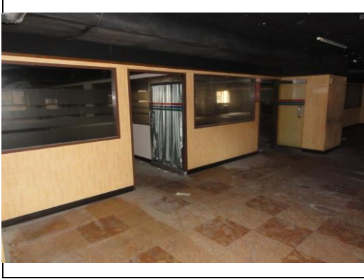
照片1：雙面牆板及玻璃隔屏全部拆除
