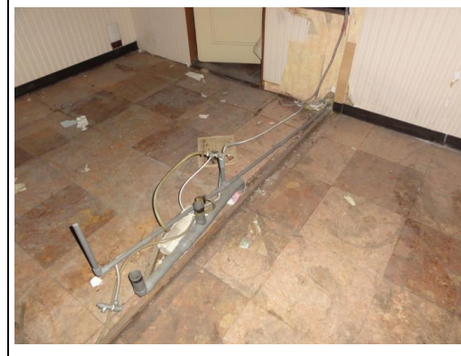
照片4：舊廚房零散管線整理拆除
