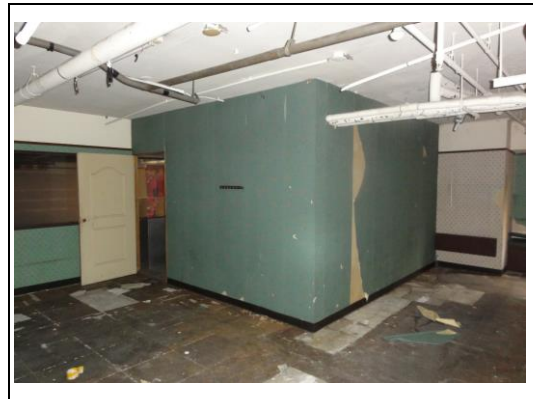
照片8：舊廚房拆除
