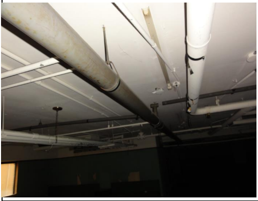
照片1：天花板4" PVC通風管路拆除
