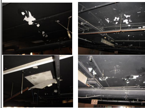
照片5：天花板舊漆剝落處鏟除
