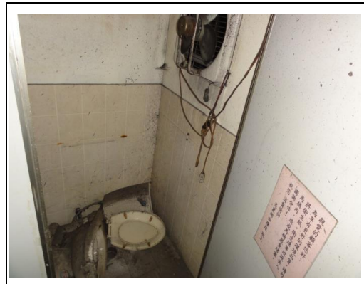
照片8：女廁馬桶拆除及抽風機拆除
