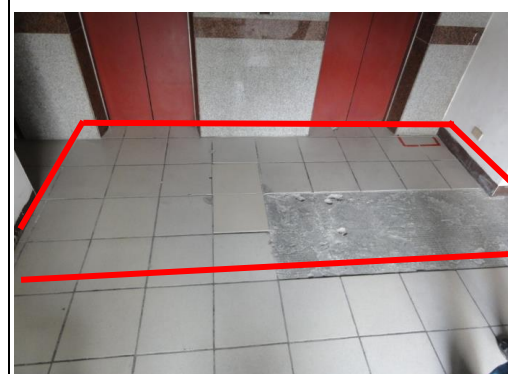
照片6：電梯口地磚部分拆除
