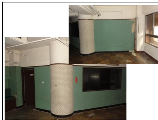
照片6：防火牆板拆除(圓柱保留)-左、中、右面
