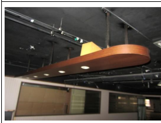
照片3：天花板舊燈具及不明管路全拆除
