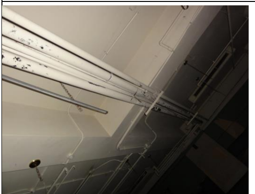
照片5：舊有冰水管路系統拆除
