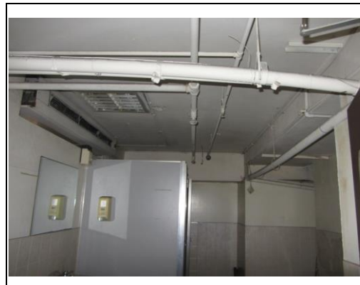
照片6：女廁拆除舊燈具後安裝新燈具
