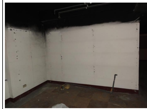
照片2：室內粉刷及補土與砂磨作業
