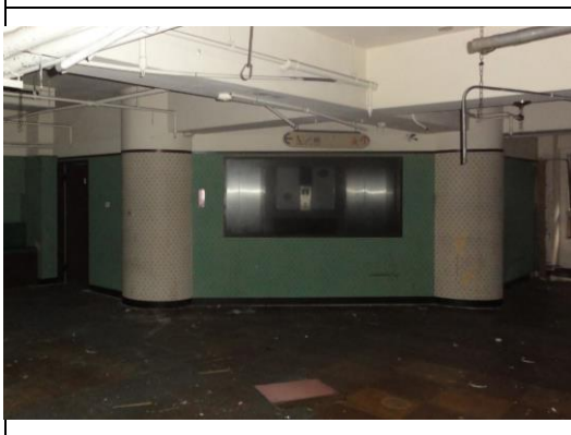
照片5：雙面防火牆板拆除(圓柱保留) - 全景
