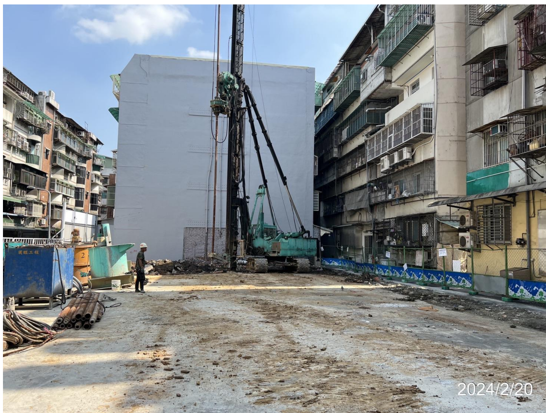
龍江路危老重建案基地現況(鄰房保護樁 418 支施作)
